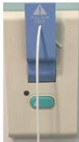
Toilet Wall Pull
